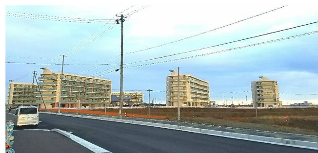
閑上の高層公営住宅
