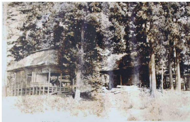
屋根改造前（昭和19年撮影）
